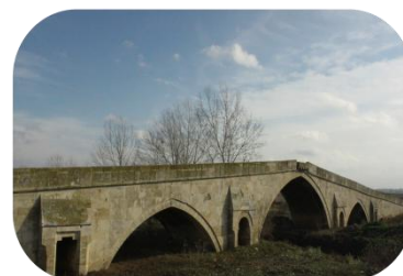
Sinanlı Alpullu Köprüsü/Alpullu Sinanlı Alpullu Bridge / Alpullu Мост Синанлъ Алпуллу
